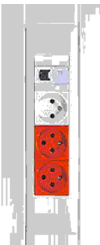
Instalacja w pomieszczeniach końcowych zakończona kanałem instalacyjnym 35x60 białym Uchwył montażowy 12 modułów z ramką wielokolorową
