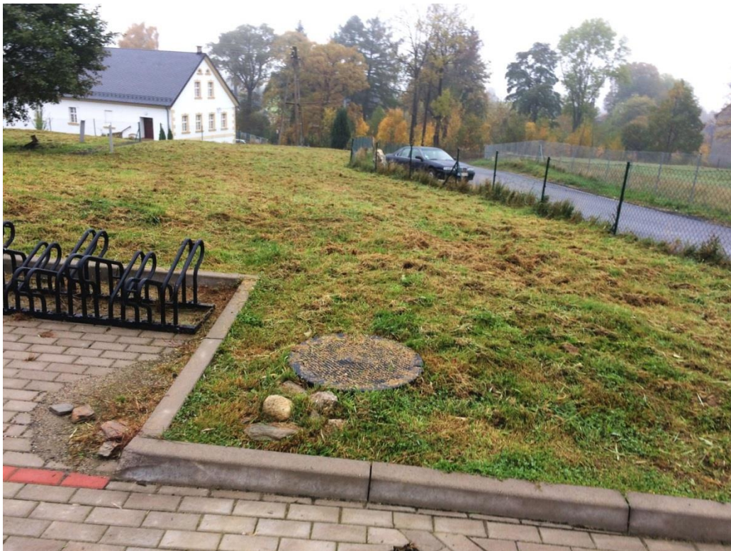
Zdj. 11 Fragment terenu do zmiany nawierzchni na kostkę betonową: obrzeże do demontażu i studzienka do obniżenia.
