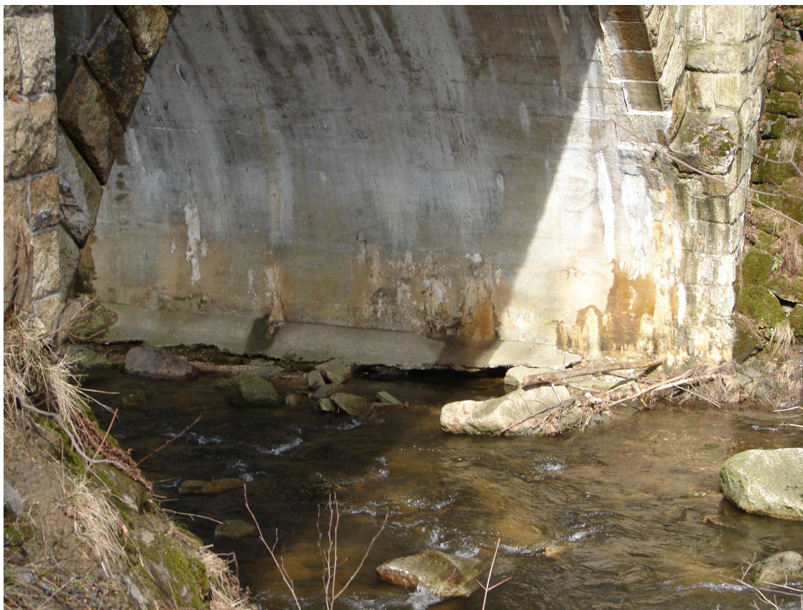
Fot.3. Widok na ubytki w odsadźce fundamentu przyczółka mostu.
