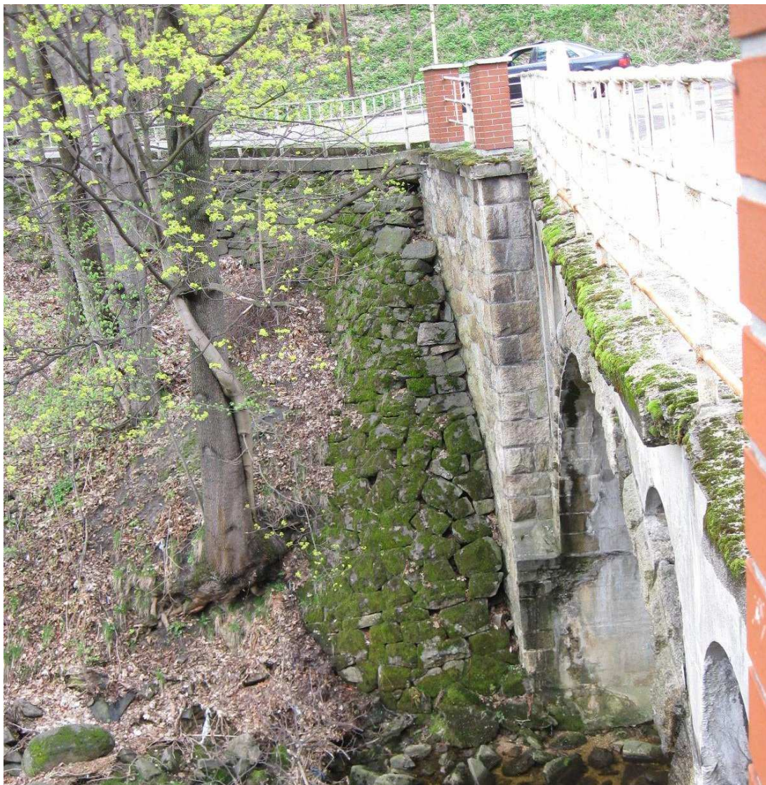
Fot.2. Widok na ubytki w kamiennej przyporze mostu ułożonej w formie stożka.
