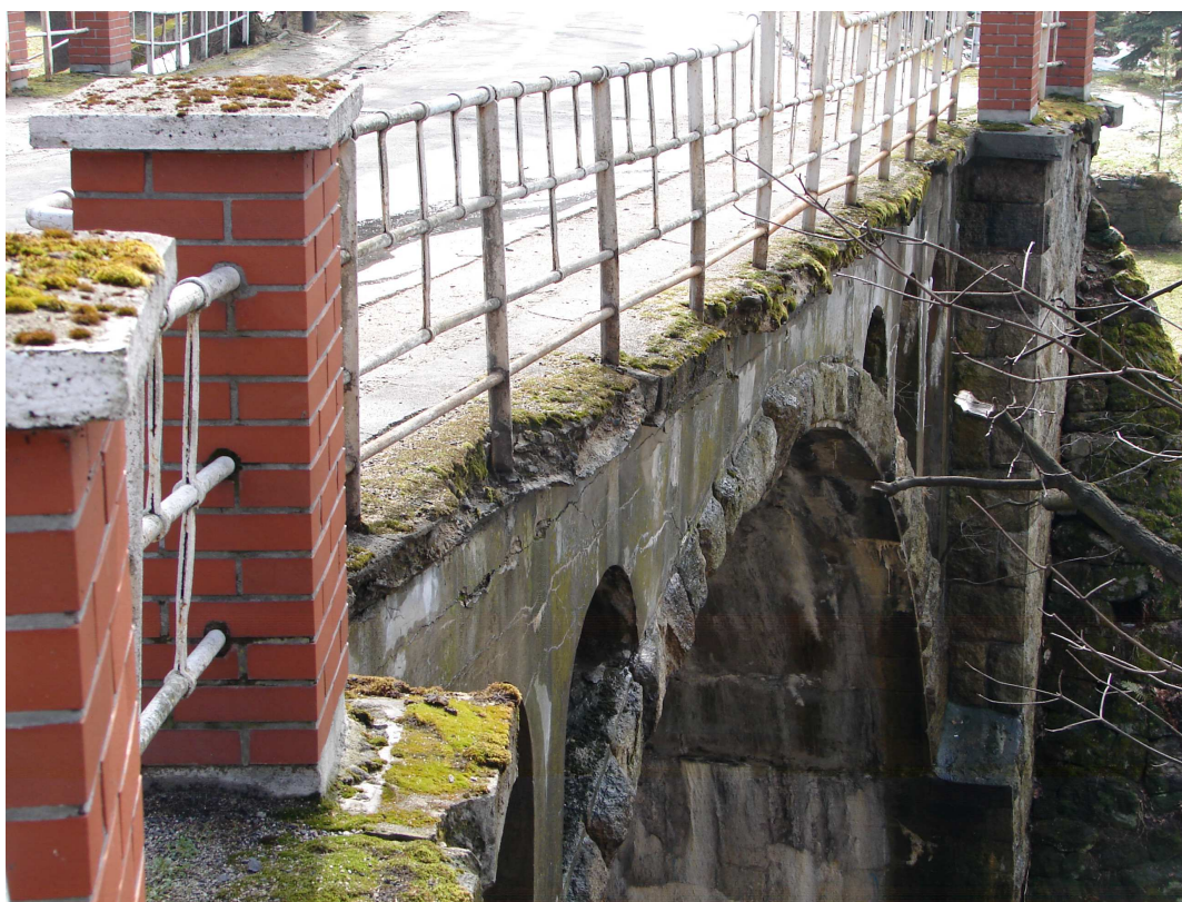
Fot.1. Widok na ubytki w czapie betonowej mostu oraz spękanie lico mostu.
