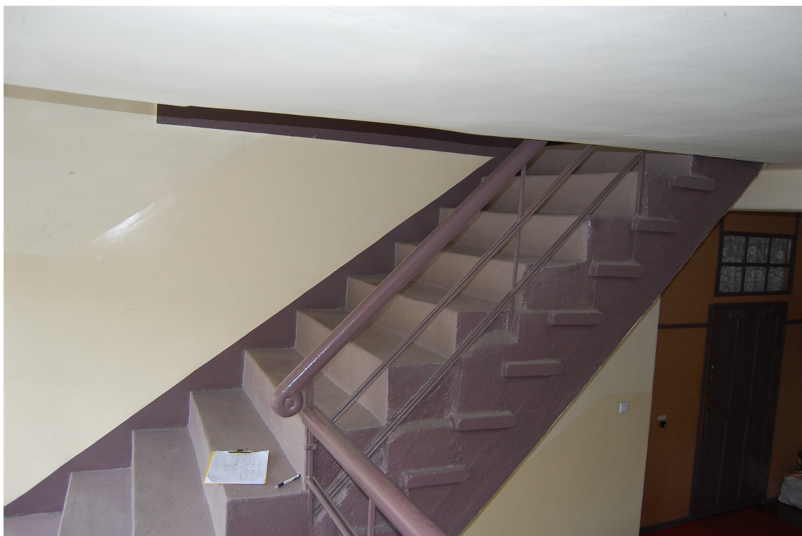
fot 7. Widok biegu schodowego do przebudowy. Na pierwszym planie fragment ugiętego stropu przeznaczanego do rozbiórki.
