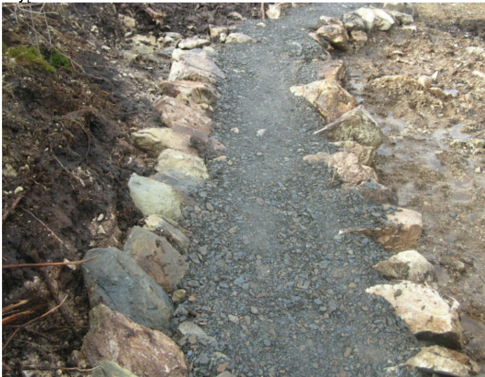
Zdjęcie 40 pokazuje warstwę podbudowy sporządzoną z mieszanki czystych kamieni łagodnie połączonych ze stokiem tuż ponad ścieżką.
