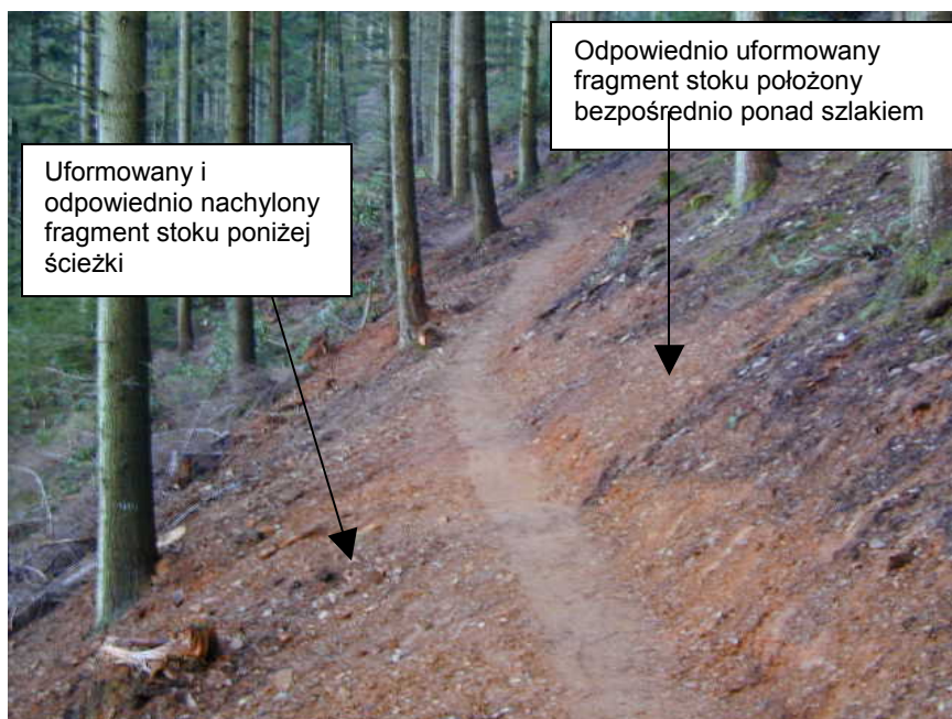
Zdjęcie 21 pokazuje szlak z właściwie wykonanymi i odpowiednio nachylonymi fragmentami stoku poniżej jak i powyżej ścieżki.
